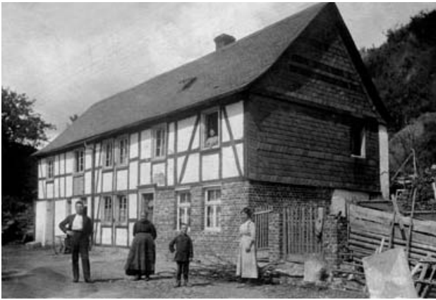
Bild 10: Das Haus der Familie Ignatz Schulte vor dem Bahnbau; links erstreckt sich später die Stahlträger-Eisenbahnbrücke, rechts über dem Haus verläuft die Bahnstrecke von Fredeburg nach Wenholthausen.
