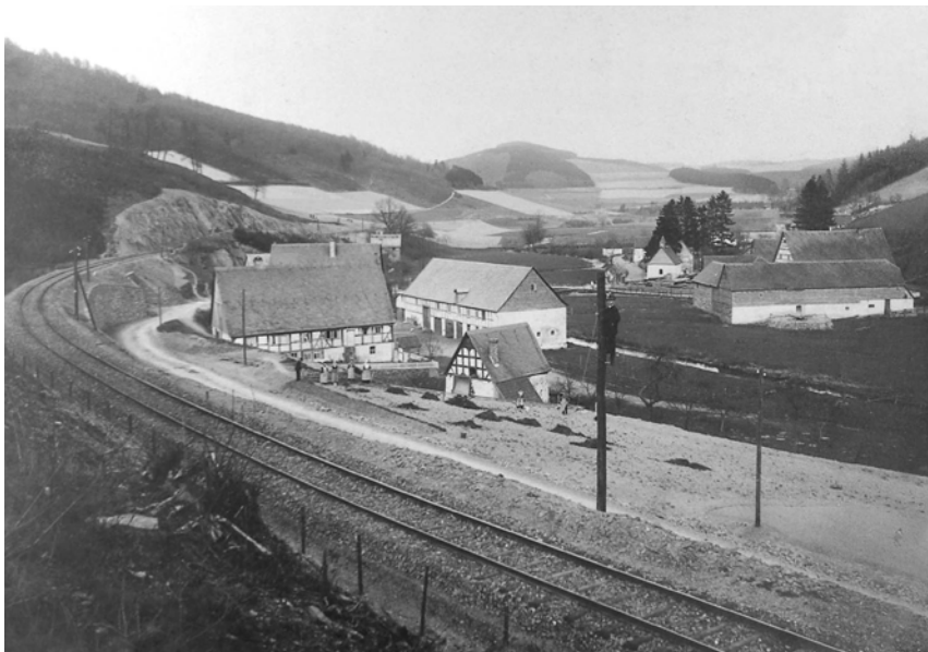
Bild 12: Die neue Bahnstrecke verläuft im Bogen um die Ortschaft Sallinghausen; Ortsbewohner vor dem Hof Mathweis und ein Arbeiter auf dem Telegrafenmasten beobachten das Geschehen.
