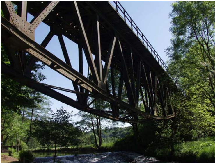
Bild 23: Ein Bild der unter Denkmalschutz stehenden Stahlträger-Fischbauch-Eisenbahnbrücke über die Wenne und L 541 bei Wenholthausen im Jahr 2009. Hier enden die restlichen Gleise der Gesamtstrecke, die nur noch auf einer Länge von ca. 2,5 Kilometer vom Bahnhof Eslohe an erhalten sind.
