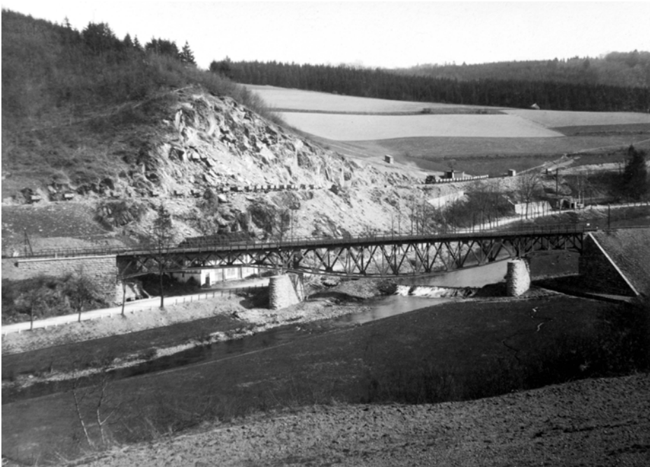
Bild 3: Eisenbahnbrücke über Wenne und Straße mit dem Haus des Ignaz Schulte um 1910. Im Hintergrund die Arbeiten an der Neubaustrecke Fredenburg- Wenholthausen mit Feldbahnloren zum Abtransport der Gesteinsmassen.
