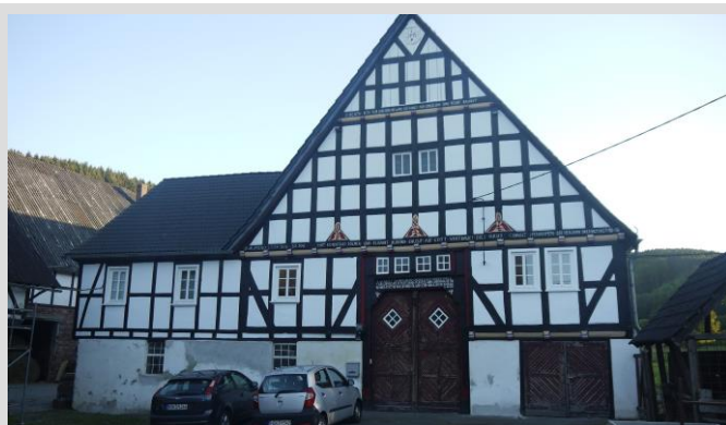
Böhmers Haus in Oberbremscheid, wie es sich heute darstellt. Die vordere Giebelseite mit seinem schmucken Fachwerk und den Inschriften wurden frisch gestrichen. Der Erhalt des 1734 erbauten Hauses, in dem Geschichte geschrieben wurde, ist dem derzeitigen Eigentümer Eberhard Böhmer ein Anliegen.
